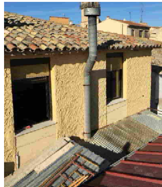
FACHADA POSTERIOR CENTRO CULTURAL
